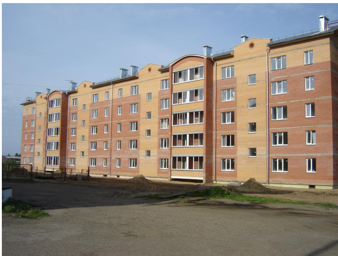
Рис. 6 Строящийся 60-квартирный жилой дом по ул. Ленина
