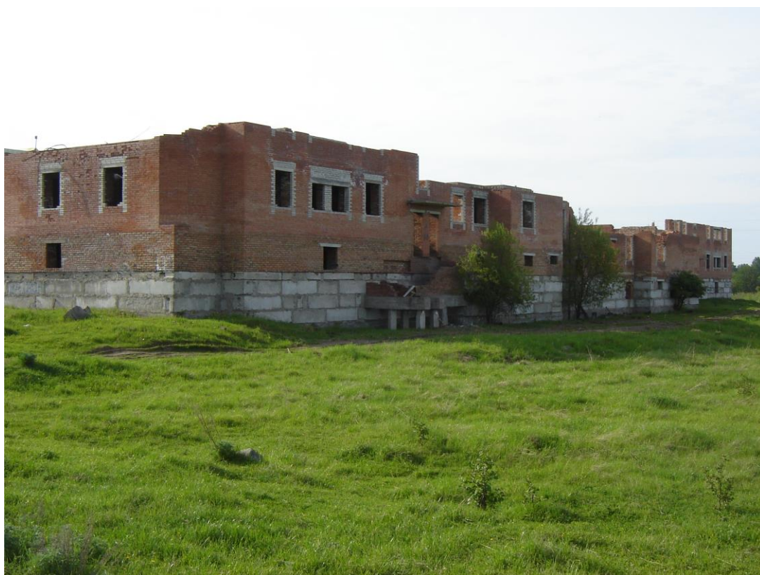
Рис. 4 Общежитие на 404 места (незавершённое строительство)
