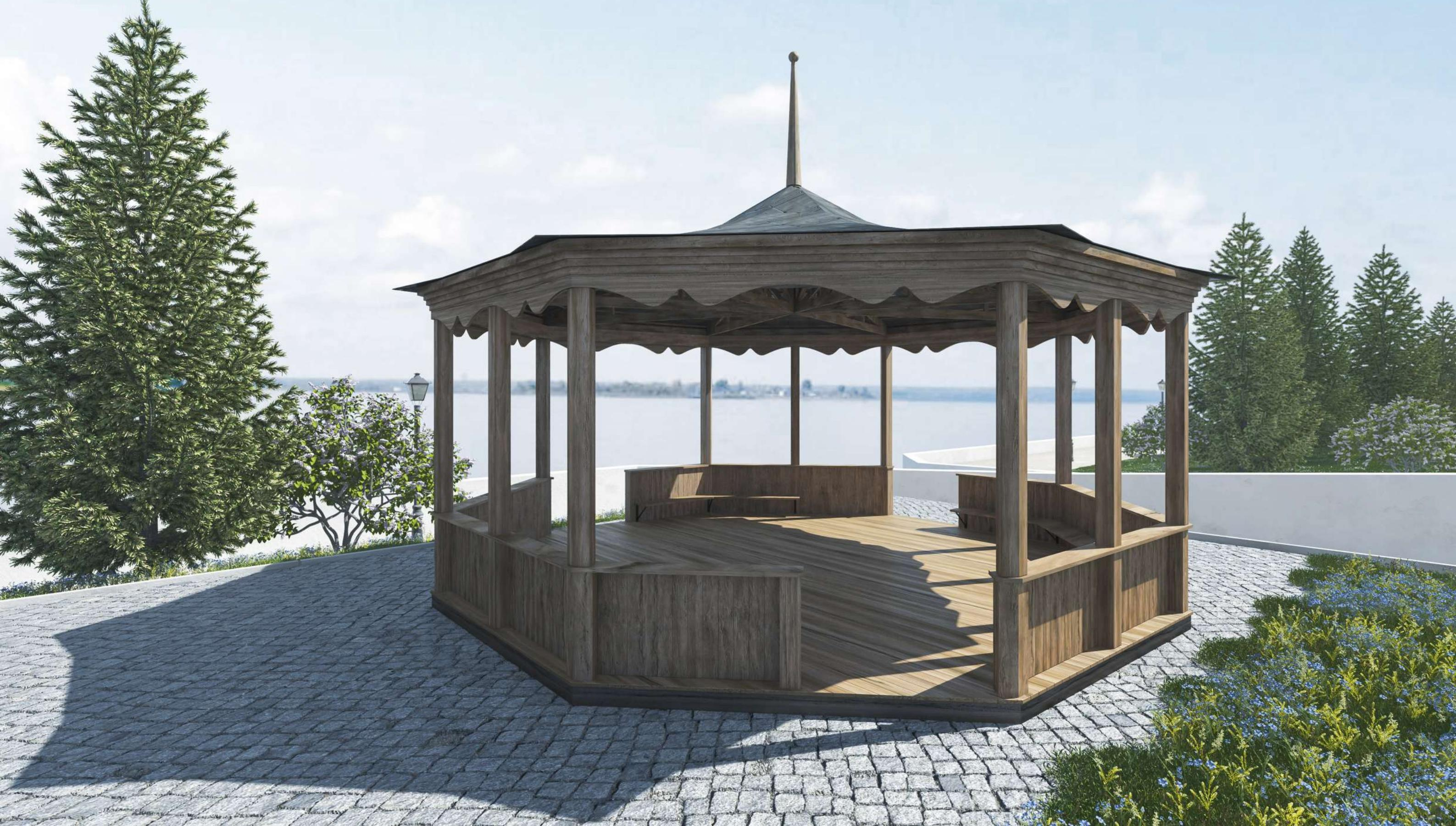
Парковая беседка, воссозданна по фотографиям Енисейска начала прошлого века. Деревянные части беседки выполнены из калиброванного бруса и доски, кровля изготовлена из листового металла.
